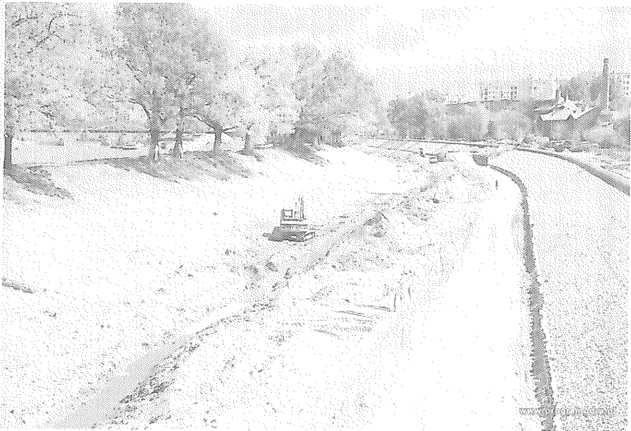
Zdj. 5. Widoczne przepuszczalne dno kanału po usunięciu uszczelniającej warstwy dennej przegłębieniu dna umożliwiającemu dostęp wód kanału do warstwy pospółki
