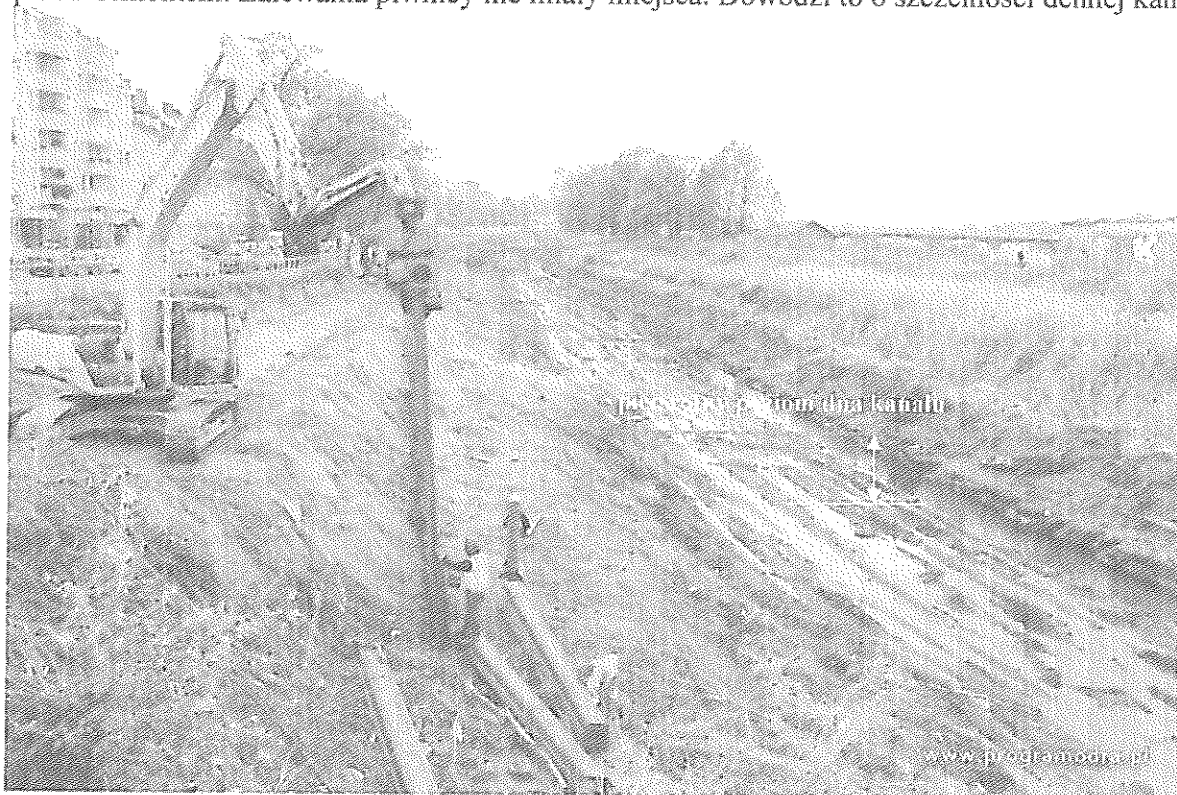
Zdj. 2. Grunty spoiste nazwane „namułami” - zaczernionymi procesami beztlenowymi. Wzdłuż Wybrzeża J. C.-Korzeniowskiego – utwory te, będące pierwotnym uszczelnieniem dna i brzegów, zostały usunięte - listopad 2013
