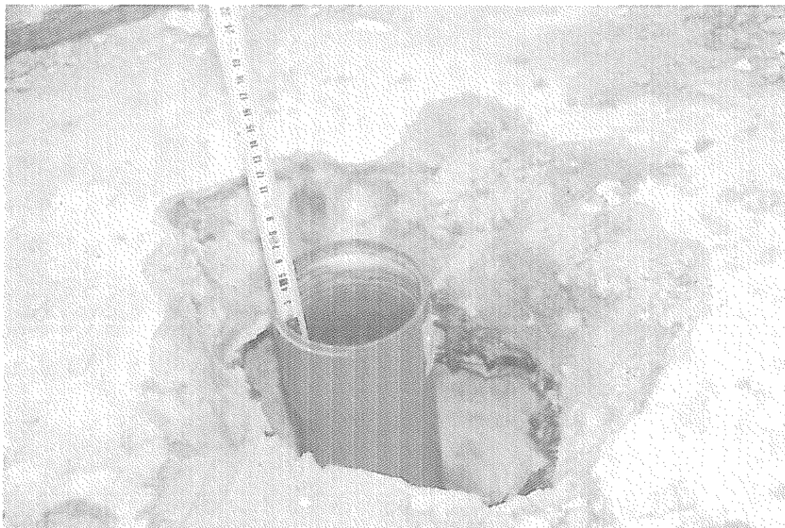
Zdj. 11. Odkrywka nr II usytuowana w południowo – zachodnim narożniku pomieszczeń przyziemia. Tutaj wielowarstwowa posadzka ma grubość około 15 cm. Poszczególne warstwy posadzki wykonano z betonu o zróżnicowanej wytrzymałości, strukturze i porowatości. Na dolnej warstwie posadzki leży warstwa folii budowlanej. Przy zagłębianiu rury nie natrafiono na grube ziarna, otoczaki, czy inne twarde elementy. Na badanej dwumetrowej głębokości grunt jest piaszczysty, im głębiej, tym bardziej gruboziarnisty.
