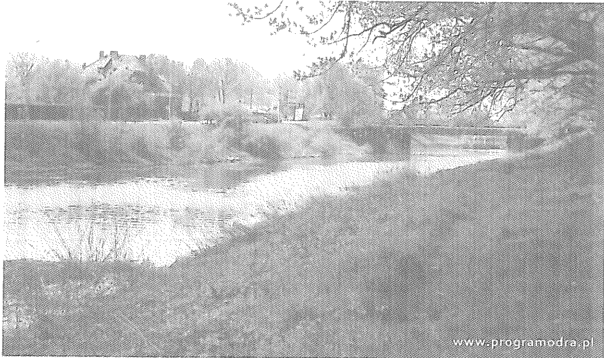
Zdj. 1. Kanał poniżej mostu Trzebnickiego (kwiecień 2011) z wysokim stanem wody z okresu przed remontem. Zalewania piwnicy nie miały miejsca. Dowodzi to o szczelności dennej kanału.
